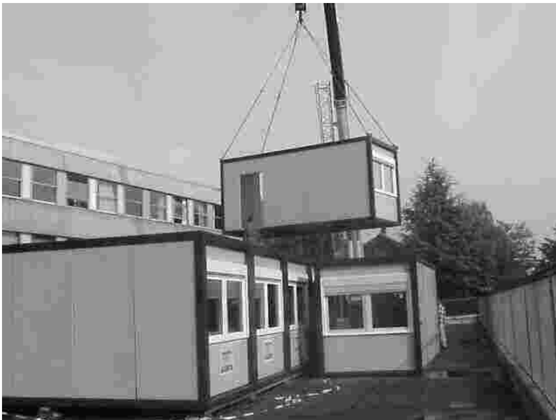
Der Aufbau der yBig Brotherp-Container geht zügig voran!
